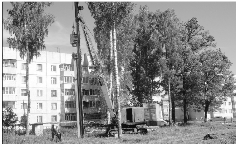
Строители устанавливают свайный фундамент.
