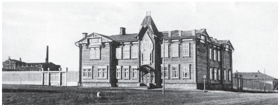
● Здание Алатырского городского училища (построено после пожара 1906 г. на месте училища, которое инспектировал И.Н. Ульянов).
