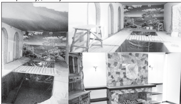
● Строящийся банный комплекс в Доме правительства.
